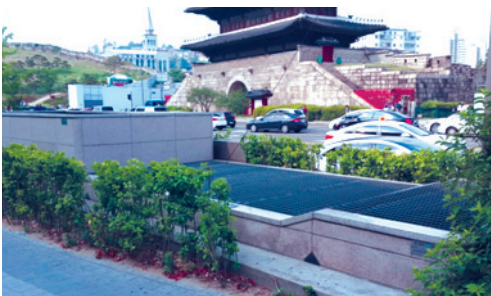
〈 그림 2-7 〉 환기구 접근방지시설 설치예시
