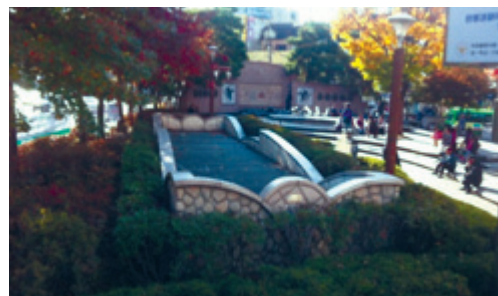
〈 그림 2-7 〉 환기구 접근방지시설 설치예시
